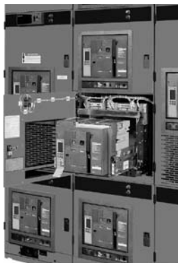
Interruptor NW removido en PZ4
